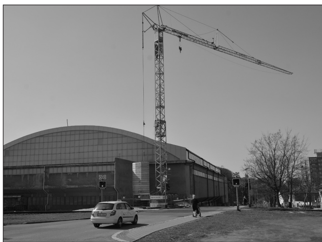
Zimní stadion se dočkal výměny střešního pláště za bezmála 15 milionů korun.
