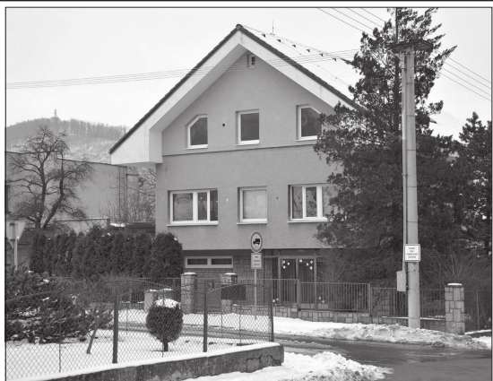
Rodinný dům, který až do loňského roku sloužil jako sídlo domova Salus, je po ukončení jeho činnosti na prodej. FOTO: DAVID MACHÁČEK
