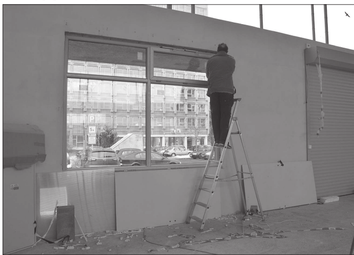
Rekonstrukce objektu bývalé tatrovácké vrátnice č. 3 se chýlí ke konci. Pracovníci dokončují úpravy vnitřních prostor včetně výmalby. FOTO: DANA HOĐÁKOVÁ
