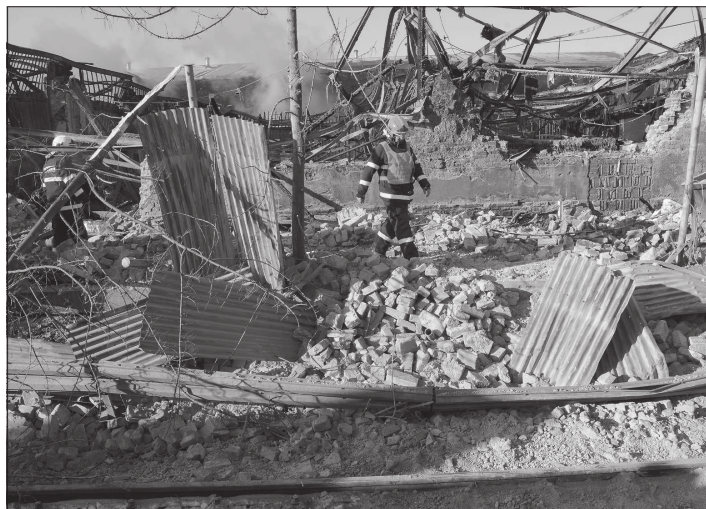
Nejnáročnějším zásahem loňského roku byla pro místní hasiče likvidace rozsáhlého požáru průmyslových hal nedaleko centra města.
