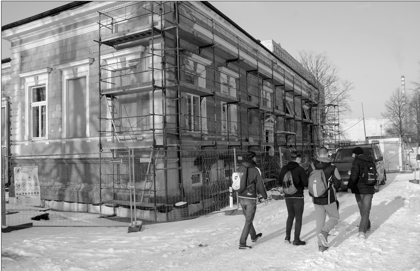
Významné místo mezi stavebními investicemi města má letos i dokončení rekonstrukce Ringhoffery vily. Nové reprezentační prostory Kopřivnice by měly být dokončeny již v dubnu.
