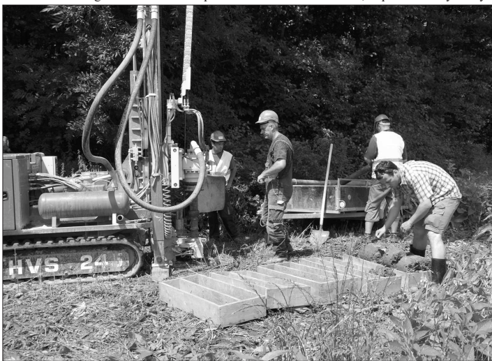
Podobně jako před lety v Lubině budou tentokrát specialisté pomoci vrtů zjišťovat složení někdejších skládky komplexní bytové výstavby. ILLUSTRACNÍ FOTO: DANA HOĐÁKOVÁ
