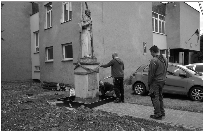
Pracovníci odborné firmy instalují pískovcovou sochu T. G. M. na nové místo u Kulturního domu ve Vlčovicích. Přemístěna byla i z důvodu plánované stavby obchvatu. FOTO: D. MACHÁČEK
