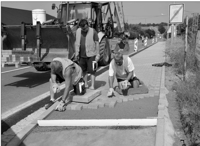
Pracovníci společnosti V + V Saveko v minulém týdnu dodládali nově postavený chodník podél komunikace na ulici Obránců míru.
