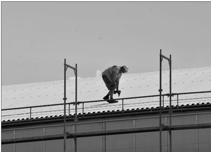
V minulém týdnu byla dokončena pokládka nové střešní krytiny na budově zimního stadionu. Rekonstrukce za téměř patnáct milionů korun bude ukončena dříve, než bylo původně v plánu.
