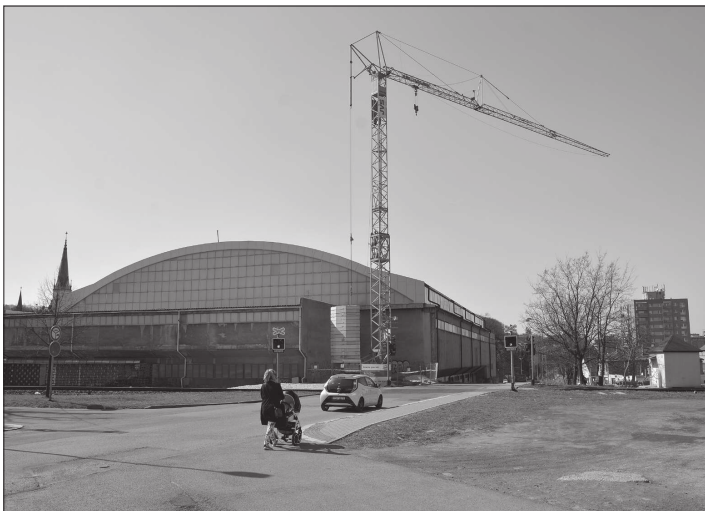
Stacionární jeřáb se nad budovou zimního stadionu tyčí už druhý týden. Samotná výměna střešního krytiny má začít v nejbližších dnech.
