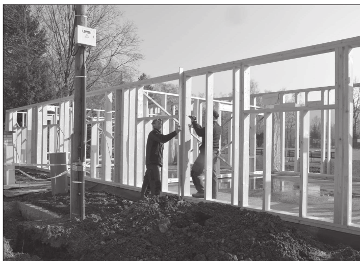
Nové šatny na hřišti ve Vlčovicích, jejichž obvodový skelet firma v současné době buduje, mají být dokončeny do prázdnin.
