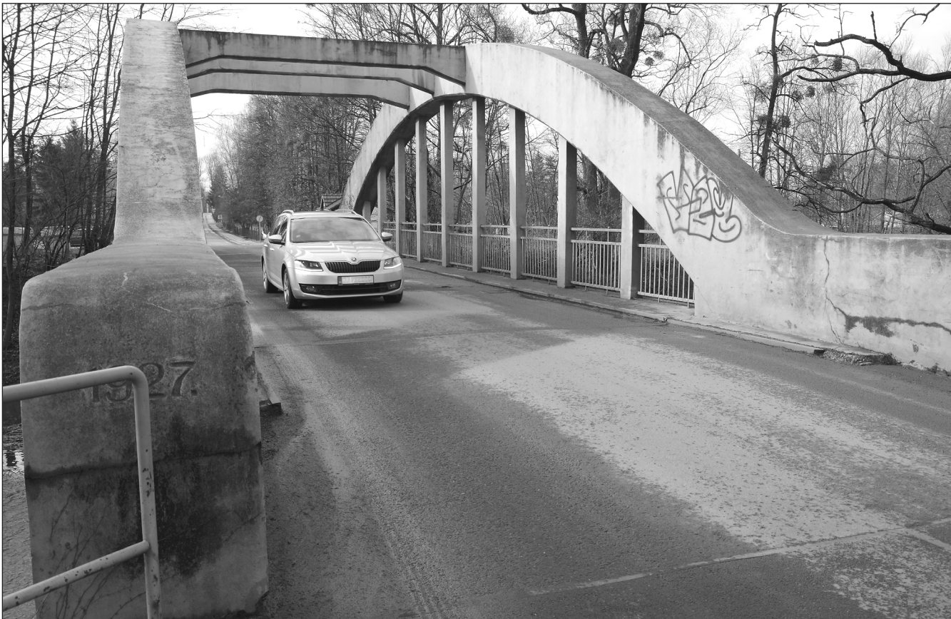
Letos se Lubinští konečně dočkají opravy mostu, po níž volali již několik let. Práce na jeho rekonstrukci budou znamenat výrazné dopravní omezení a mnohakilometrovou objížďku.
