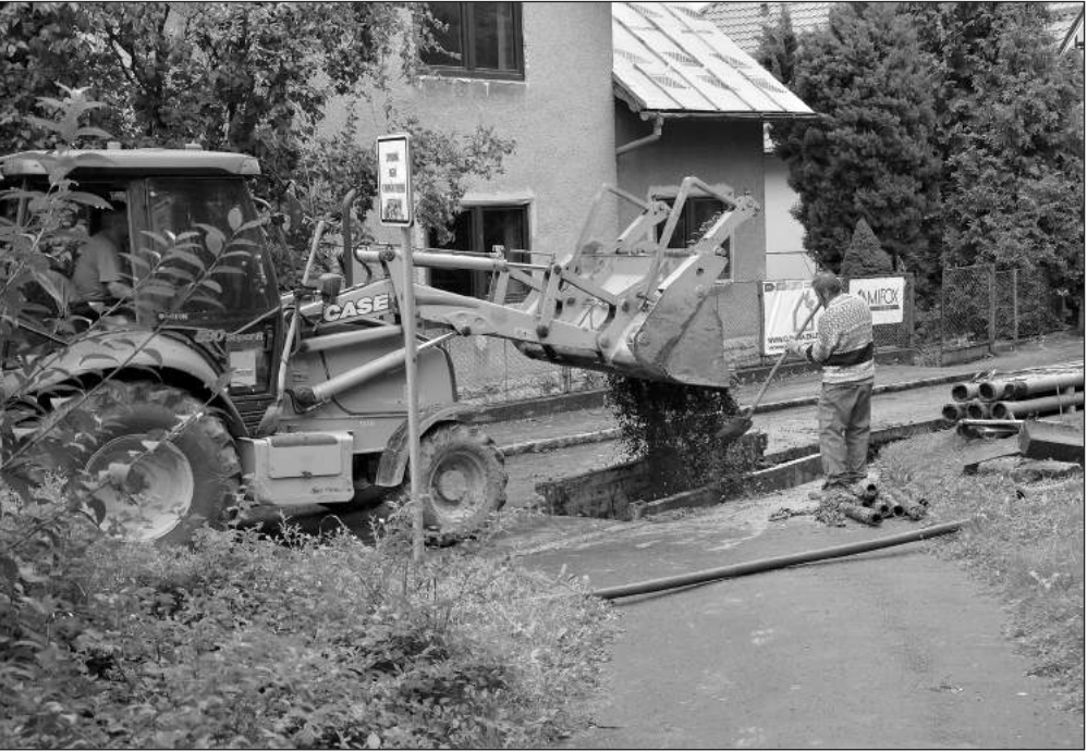
Vloni SmVaK investoval do obnovy vodovodů v Kopřivnici téměř 13 milionů. Letos se rekonstrukce vodovodního řadu dočkají v Lubině.
