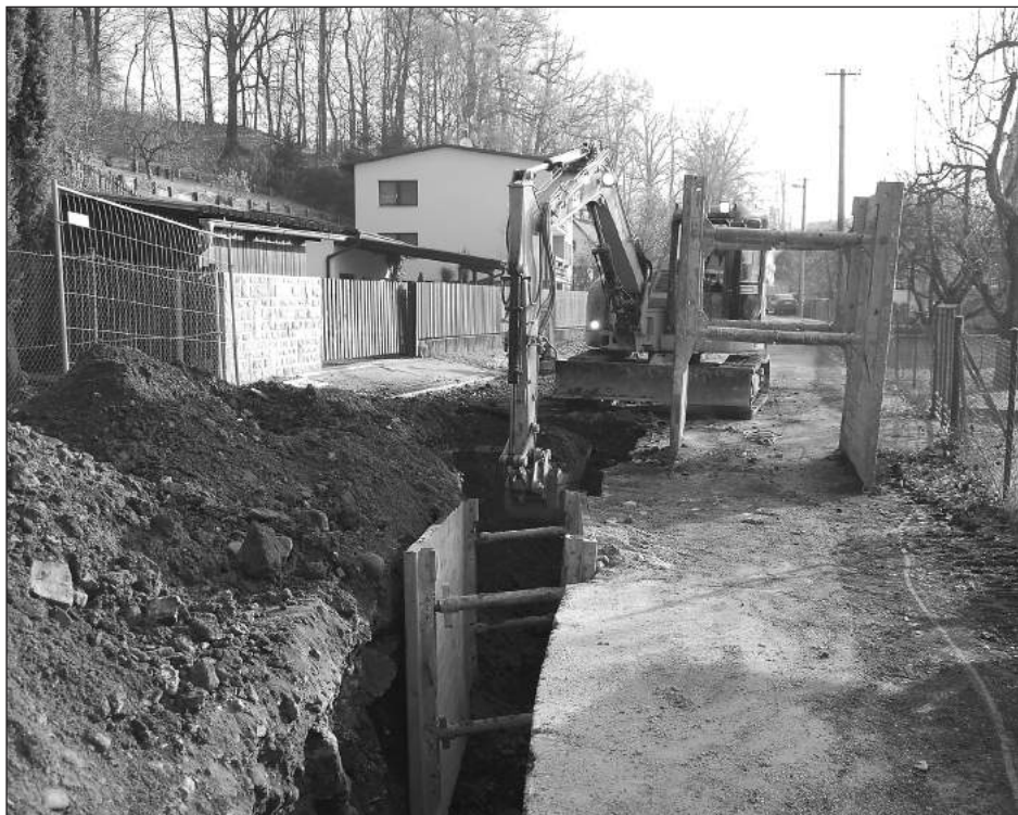
Stavba kanalizace v Lubině byla největší investicí města za poslední léta. Nyní podobný projekt připravuje město pro Vlčovice a Mniší. FOTO: DAVID MACHÁČEK
