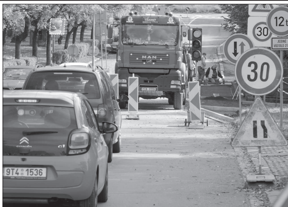
Úpravy vozovky a chodníků na Husově ulici s sebou nesou dopravní komplikace. Provoz na rušné ulici řídí semafor. FOTO: DAVID MACHÁČEK
