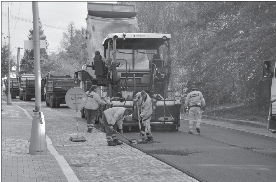
O státním svátku 28. září byla položena na rekonstruované komunikaci ulice Štramberské finální, třetí vrstva asfaltu. Veškeré stavební práce by firmy měly dokončit do 17. října.
