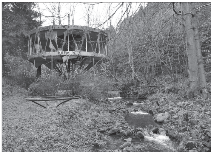
Torzo netradičního rekreačního objektu na úpatí Lysé hory chce zachránit dvojice architektů z kopřivnického studia KLAR.
