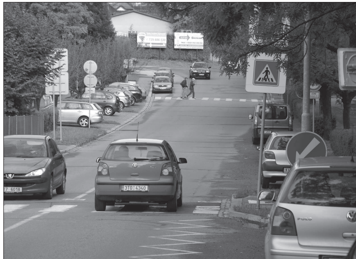
V příštím týdnu začnou stavební práce, během nichž vznikne spojovací chodník, upraví se přechod před potravinami a budou vybudovány dva odbočovací pruhy. FOTO: D. MACHÁČEK
