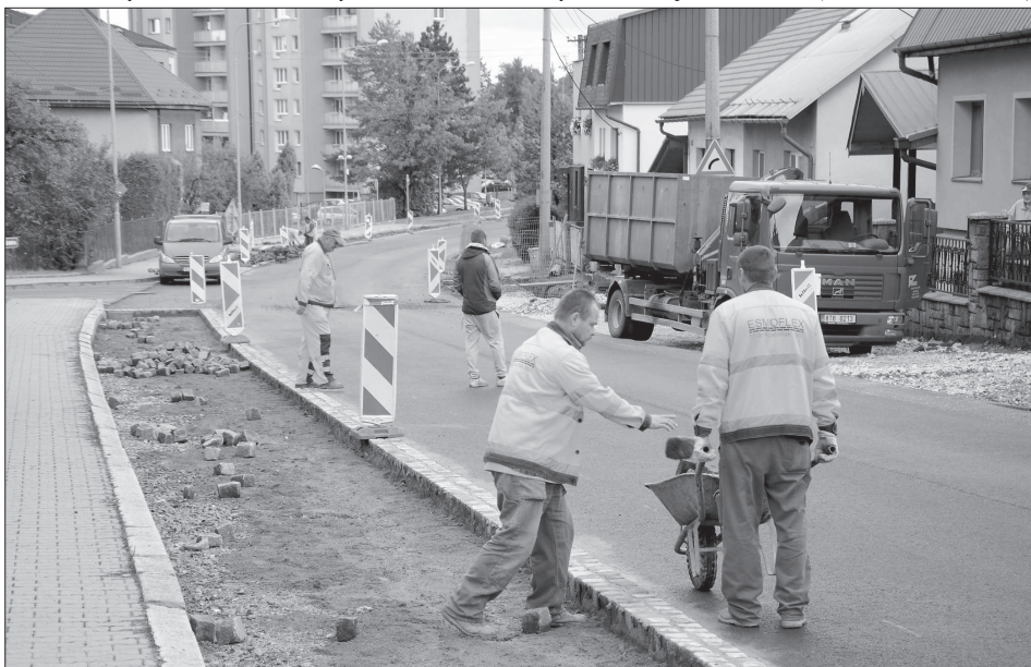
Stavební práce na rekonstrukci ulice Štramberské mají být dle smlouvy dokončeny do 17. října. Sdružení firem tak finišuje s pracemi, aby mohla být v sobotu 23. září položena finální vrstva asfaltu.
