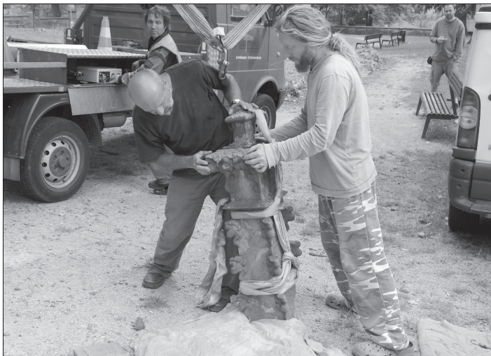
Pískovcové fiály z průčelí hrobky rodiny Šustalů restaurátoři opatrně sejmulí a nyní na nich budou pracovat v dílně ve Vendryni. FOTO: DAVID MACHÁČEK
