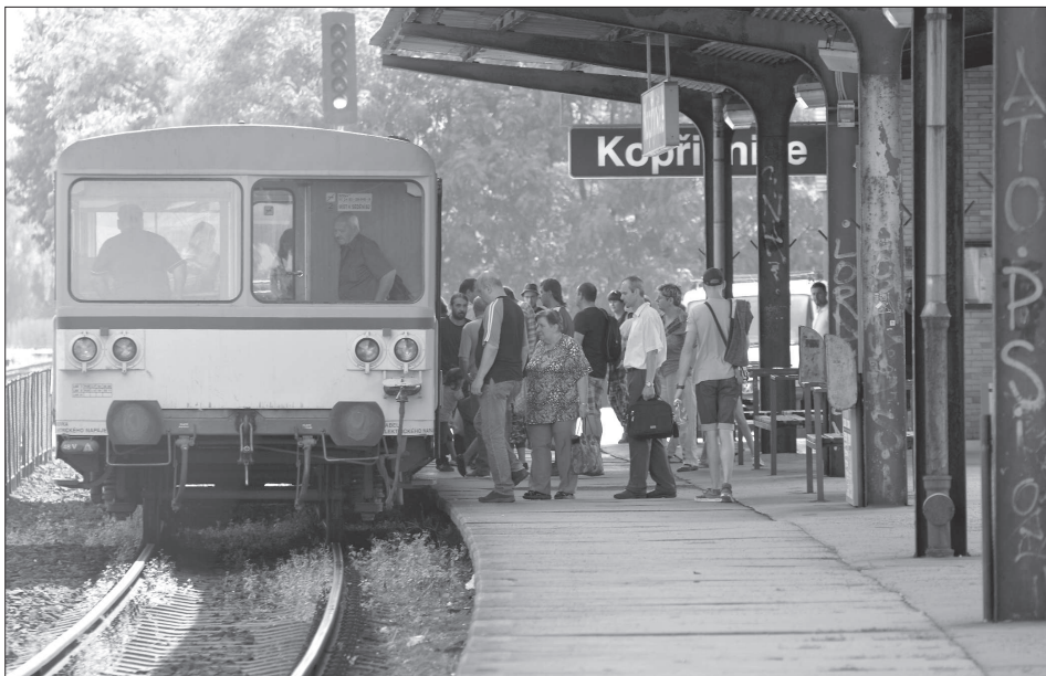
Vlakové nádraží se dočká provizorních úprav ještě do konce letošního roku. Komplexní rekonstrukce nádražní budovy i nástupišť pak proběhne zároveň s elektrifikací trati.
