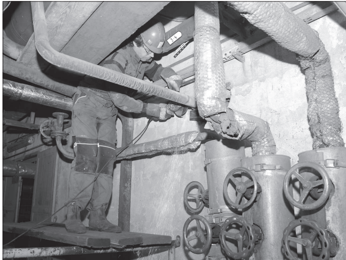
V rámci letní odstávky byla v prostorách teplárny společnosti Komterm prováděna plánovaná údržba i opravy drobnějších havárií, které se vyskytly v průběhu roku. FOTO: D. MACHÁČEK
