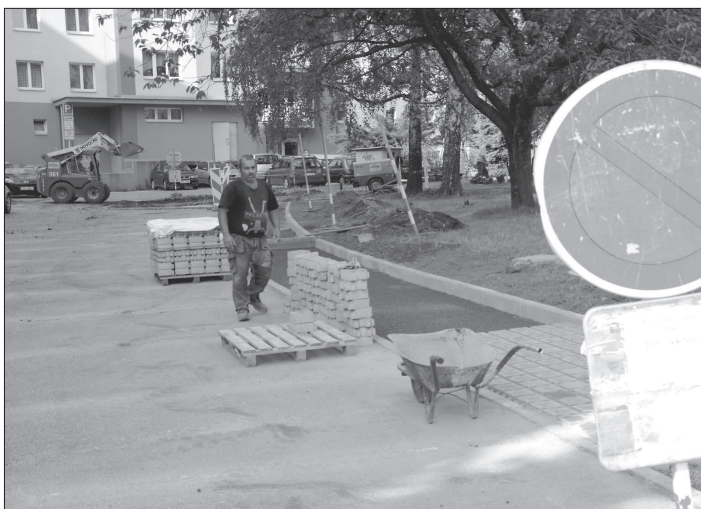
Tri týdny stavebních prací na ulici Kadláčkově přinesly nejen zlepšení průjezdnosti, ale i nová místa pro odstavení vozidel. FOTO: DAVID MACHÁČEK
