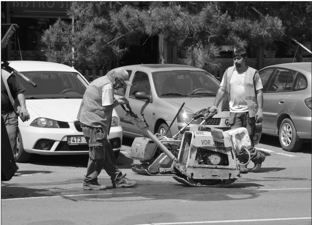
Opravy výtlučků na komunikacích v Kopřivnici provádí Slumeko i v místech, které byly v zimě provizorně vyspraveny. FOTO: DANA HOĐÁKOVÁ
