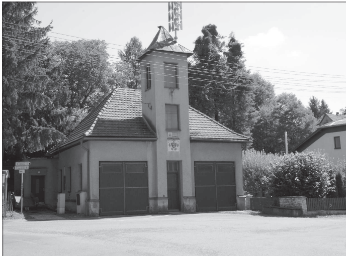
Požární zbrojnice sboru dobrovolných hasičů Lubina II ve Větrkovicích čeká na opravu střechy, se kterou počítá rozpočet města na letošní rok.
