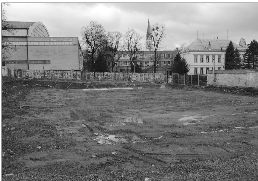
Prostranství po bývalých sklenicích se do června změní v parkoviště s kapacitou 39 stání. Přerušené stavební práce začnou každým dnem. FOTO: D. MACHÁČEK
