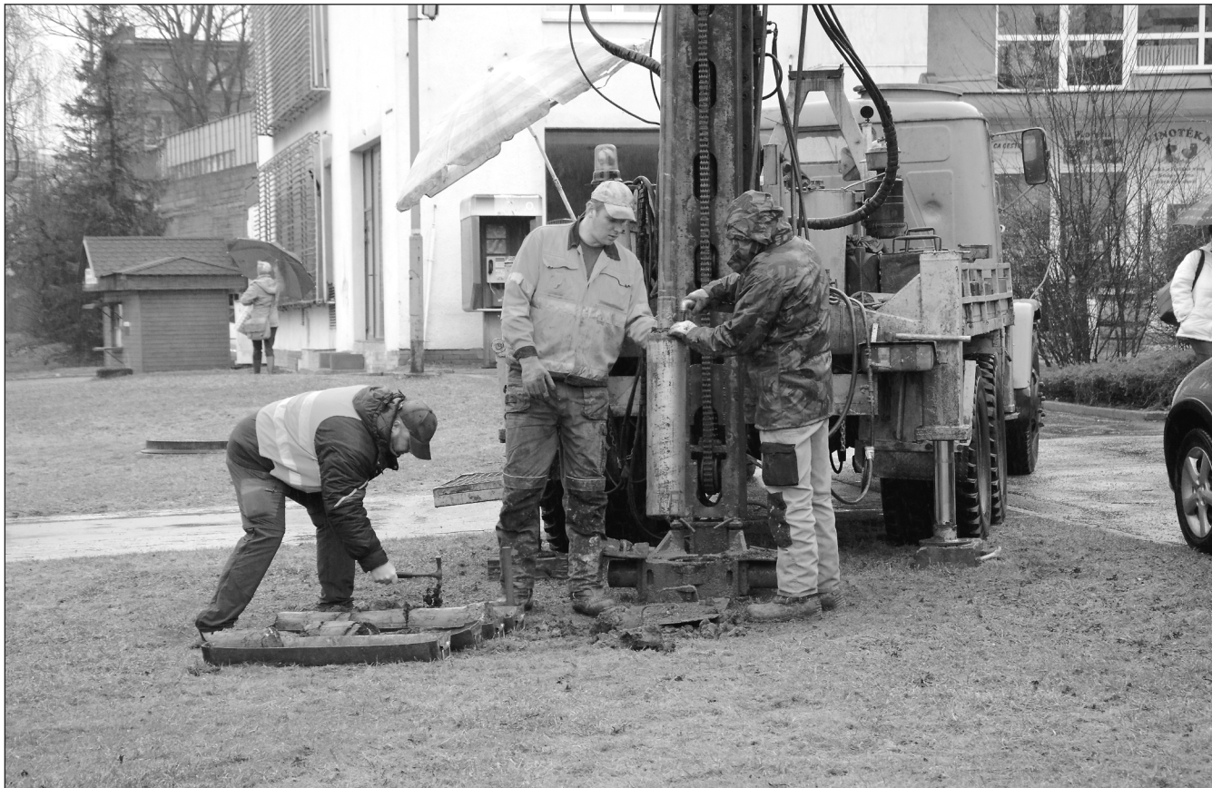
Pracovníci specializované firmy provedli v centru města několik vrtů, jejichž prostřednictvím zjišťovali stav podloží, který musí projektanti znát pro přípravu na rekonstrukci této části Kopřivnice.
