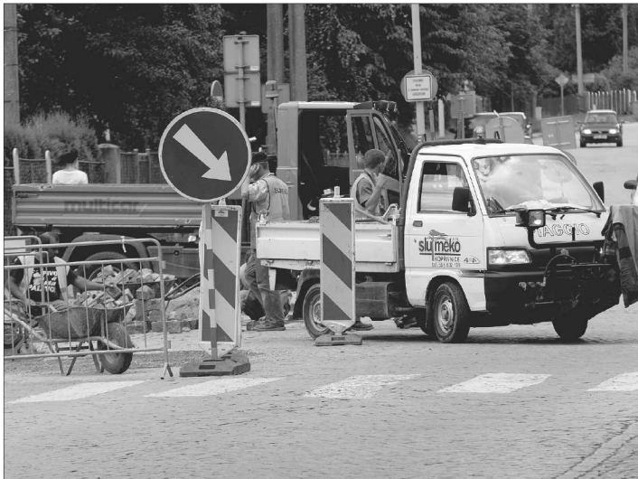
Tento úsek ulice Štramberské, který pracovníci Slumeka předkládali v létě 2011, by se měl dočkat kompletní rekonstrukce už v příštím roce. FOTO: DAVID MACHÁČEK
