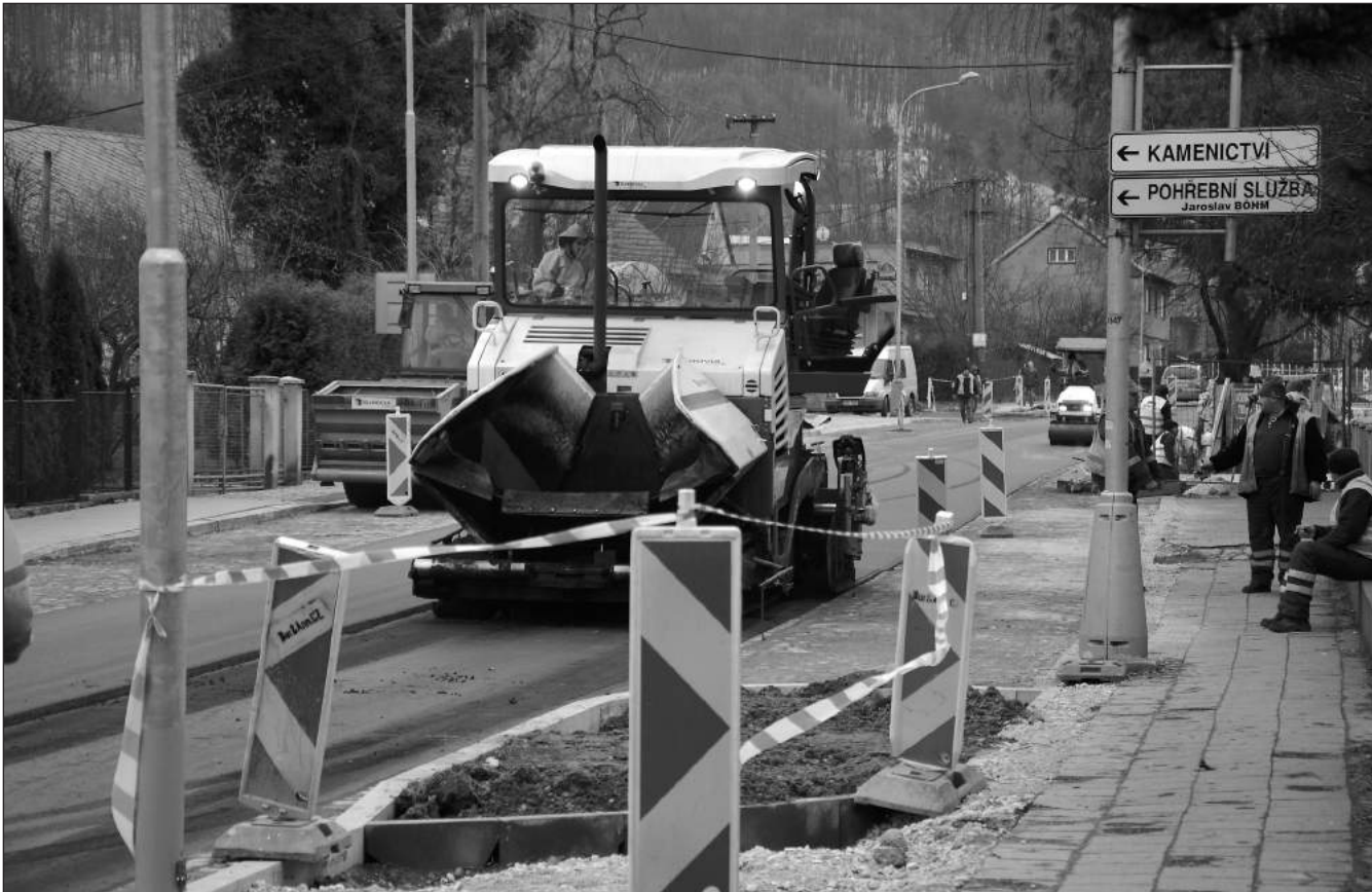
V pátek 9. prosince byla na opravený druhý úsek I. etapy rekonstrukce ulice Štramberské položena třetí, finální vrstva asfaltu. V tomto týdnu měly být vyasfaltovány dva chybějící sjezdy na ulici Hřbitovní a Smetanovu. FOTO: DAVID MACHÁČEK
