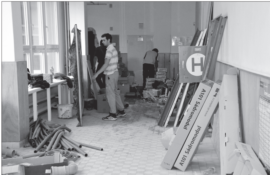
Tři dny po původním termínu dokončení rekonstrukce sociálních zařízení na ZŠ Alšovce jsou chodby této školy stále staveništěm. Radní museli narychlo projednat odložení začátku školního roku. FOTO: DAVID MACHÁČEK
