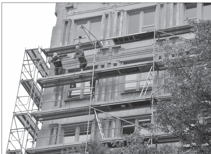
Začátkem týdne začaly přípravné práce zateplení severního štítu budovy kopřivnické radnice.
