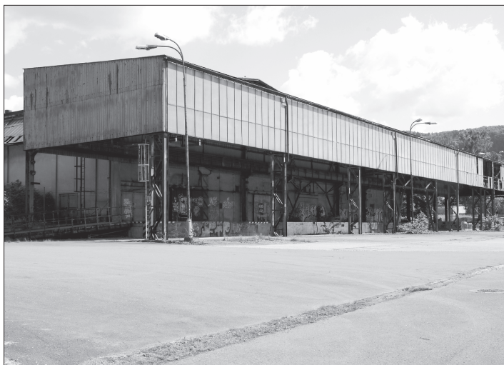
Nevyužívaný objekt bývalé slévárny poblíž vlakového nádraží je znovu zvažovaným místem pro možný přesun muzea automobilky Tatra.
