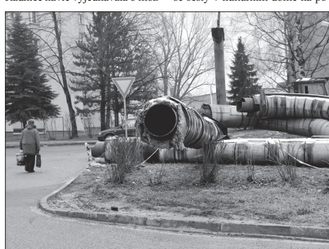
Město se v úvodu roku dočkalo odstranění potrubí nadzemního horkovodu v lokalitě Pod Morávií.
