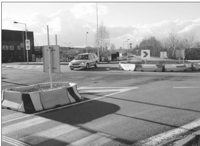
Výkop části pozemků a komunikace na ulici Ke Křížku má vyjasnit majetkové vztahy a zamezit případným budoucím problémům při užívání kruhového objezdu a cyklostezky. FOTO: DAVID MACHÁČEK
