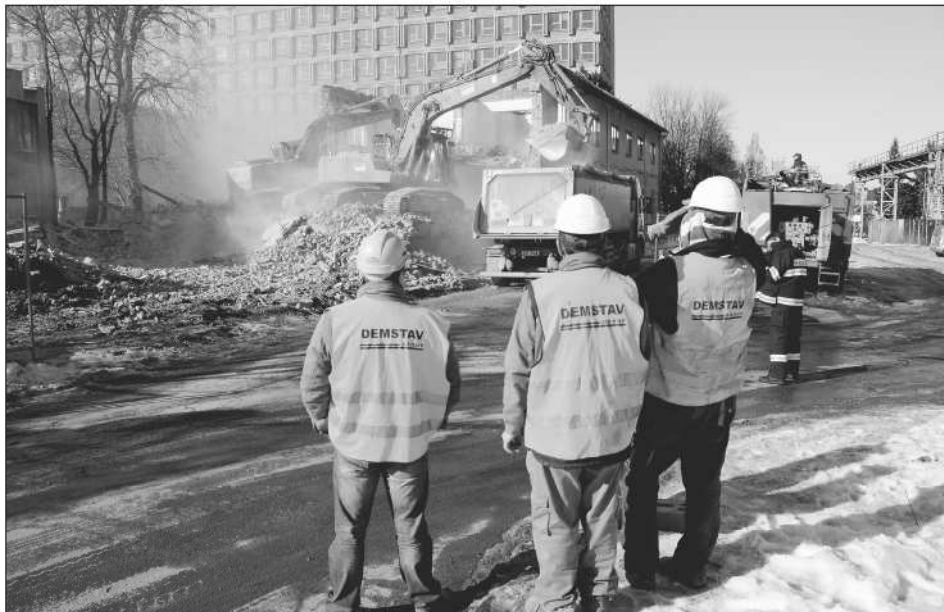
V sobotu 14. února brzy ráno se do někdejšího zdravotního střediska Tatro zakusly demoliční stroje. Během víkendu nevyužívaný objekt srovnaly se zemí a nyní pokračuje odvoz sutě a sanace terénu. FOTO: DAVID MACHÁČEK
