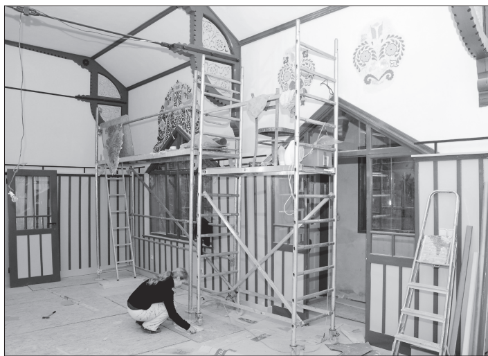
Po stavebních pracích přišly na řadu vnitřní dekorativní výmalby Jaroňkovy útulny. V celé kráse ji návštěvníci budou moci spatřit na začátku příští turistické sezony.
