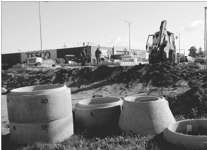
Automatická čerpací stanice pohonných hmot vyrůstá na pozemcích společnosti Tesco v Kopřivnici. Bude teprve čtvrtá svého druhu v republice.
