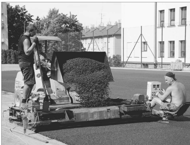
Na sportovním hřišti u ZŠ Emila Zátoka začaly práce na pokládce speciálních povrchů. Firma musela na vyzrcutí podkladových vrstev a dostala se do skluzu. FOTO: DAVID MACHÁČEK
