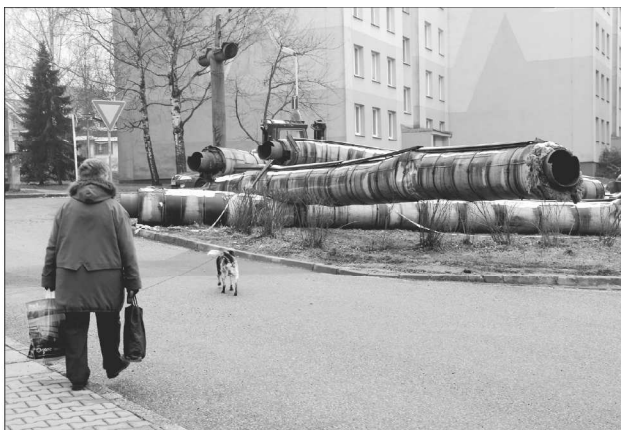
Nadzemní horkovod mizí pomalu z centra města. Většina potrubí už je demontována, nyní se musí zbavit izolace a pak přijdou na řadu podpěry. FOTO: DAVID MACHÁČEK
