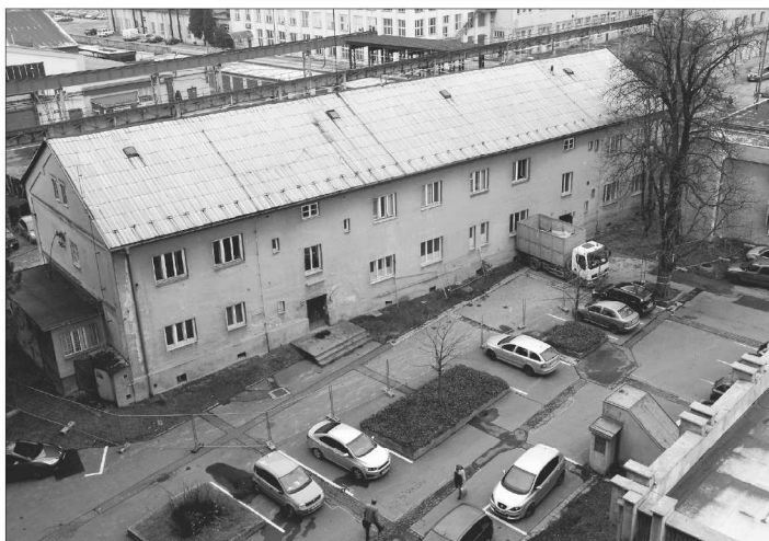
Už tento týden zmizí z bývalého domu lékařů střecha, příští víkend už by měl jít k zemi celý objekt. Demolice přinese omezení nejen pro pěší, ale i dopravu.
