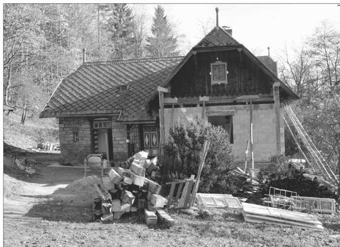
Archivní snímek hájenky z roku 2014 ilustruje rozsah rekonstrukce. Původní roubenou část stavby nahradí cihlové zdi, nové i krov. Prodej objektu má pomoci opravy dokončit. FOTO: DAVID MACHÁČEK
