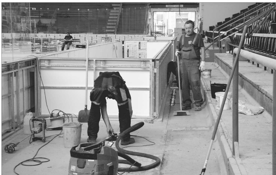
Dělníci v minulých dnech dokončovali práce na montáži zcela nových mantinelů a ochranných skel na místním zimním stadionu. Sportovci budou moci ledovou plochu začít využívat na začátku září.
