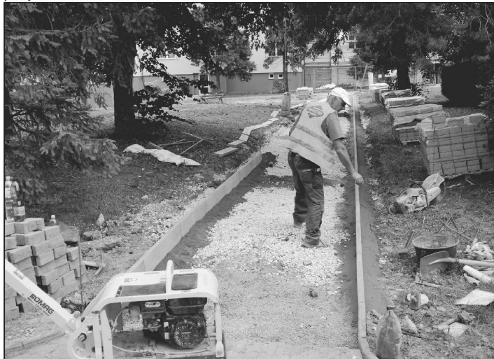
Do konce listopadu budou dokončeny veškeré úpravy na sídlišti Jih. Díky ušetřeným penězům bude rozsah provedených prací, větší než se čekalo.
