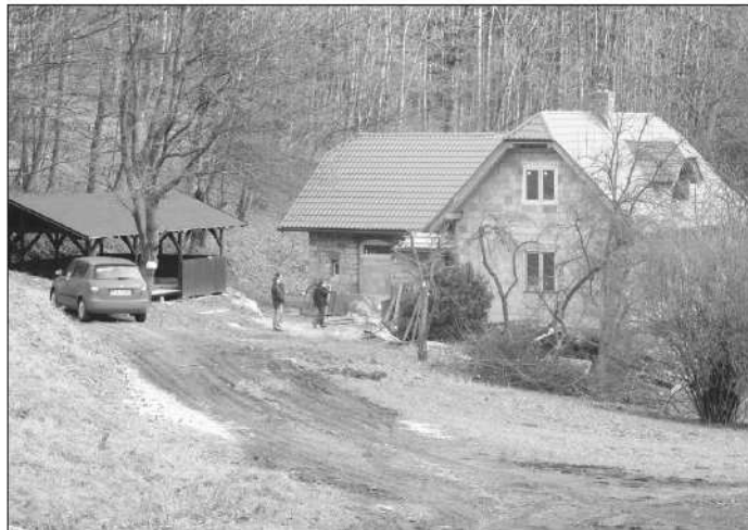
V podstatě nová stavba stojí po třech letech rekonstrukce v místě bývalé Hájenky v Janíkově sedle. K jejímu dokončení budou ale zapotřebí ještě další peníze.
