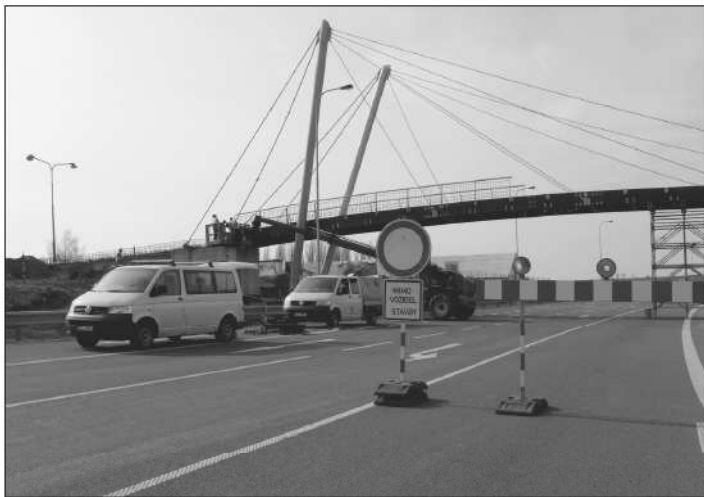
Lávka, která byla nainstalována přes silnici 1/58 na obchvatu Příbora, umožní bezpečný přechod přes komunikaci jak pěším, tak i cyklistům
