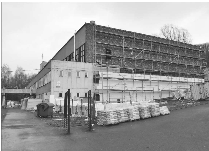
Sportovní hala zdejší střední školy se dočká nejen kompletního zateplení vnějšího pláště, ale také rekonstrukce interiéru včetně šaten a sociálních zařízení.
