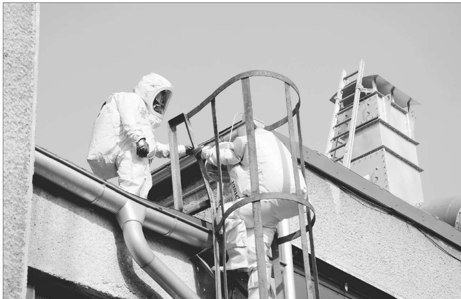
Hasiči v ochranných protichemických oblecích stoupají k absorpční pračce instalované na střeše zimního stadionu. V rámci pondělního cvičení testovali účinnost zařízení sloužícího k likvidaci nebezpečného čpavku. FOTO: DAVID MACHÁČEK
