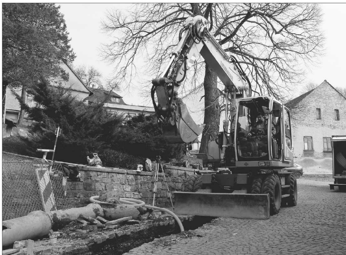
Rekonstrukce kanalizace ve Štramберку v lokalitě Kopec zkomplikuje na dva měsíce dopravu místním občanům. FOTO: ILONA MAZALOVÁ
