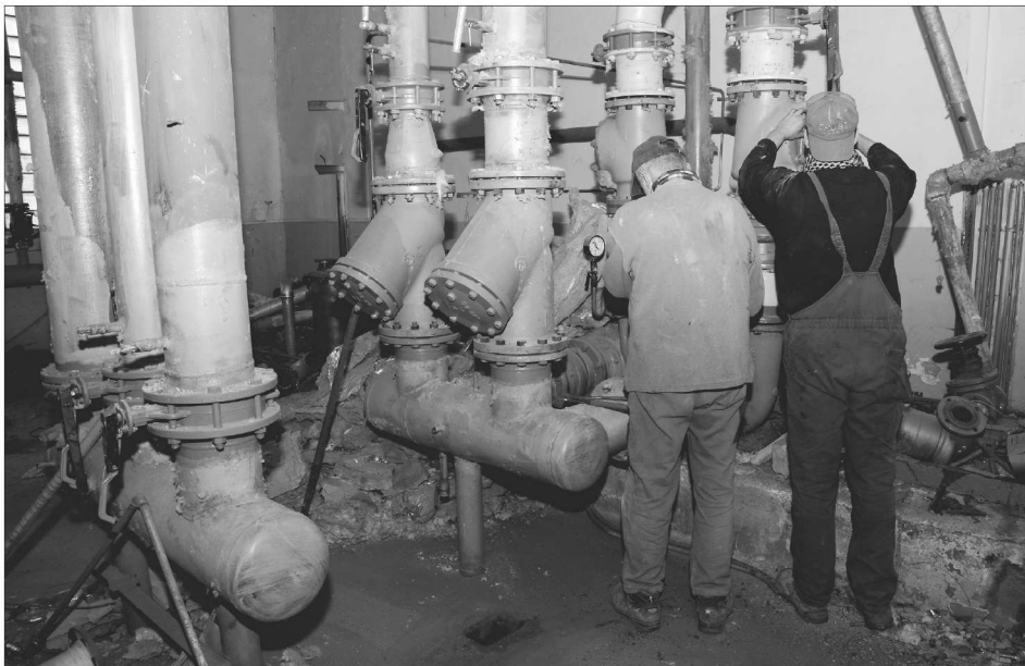
Začala demontáž technologií z nevyužívaných výměníkových stanic po celé Kopřivnici. Jejich vyklizení radnice nezaplatí, ale naopak ještě inkasuje 1,6 milionu korun.
