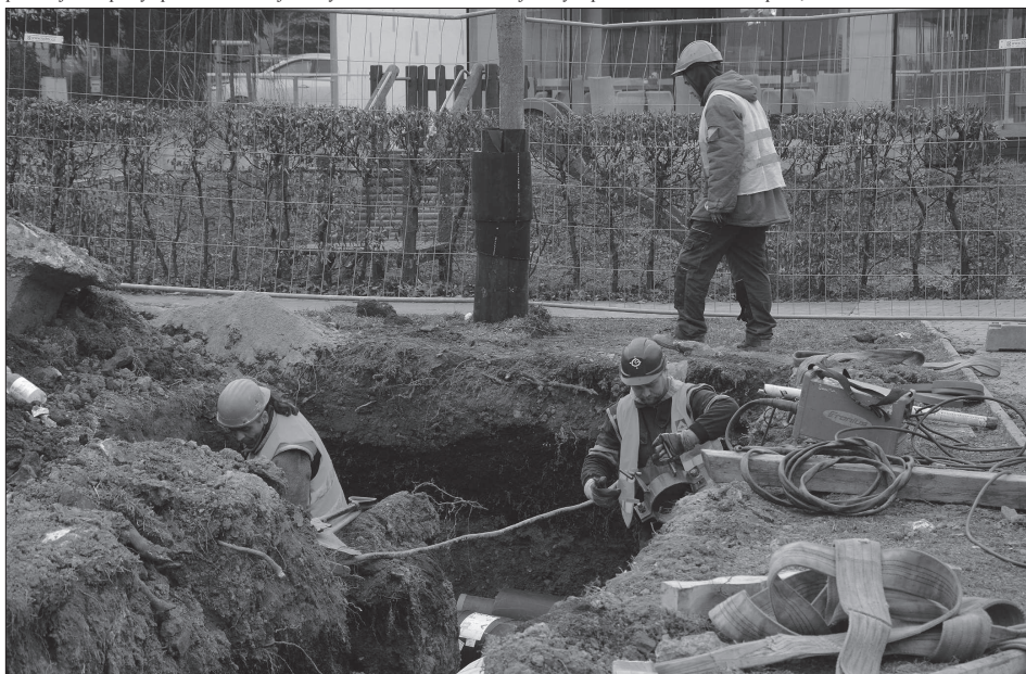
Z celkových dvě stě dvaceti milionů korun, které bude stát rekonstrukce tepelných rozvodů, bylo doposud proinvestováno zhruba čtyřicet. Dokončeny jsou tři ze čtrnácti kilometrů nového potrubí.
