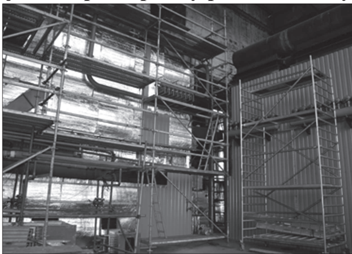
Společnost Komterm na podzim finišovala s dokončovacími pracemi na novém kotli na spalování biomasy. Tato investice má snížit cenu pro zákazníky napojené na centrální vytápění. FOTO: DANA HOĐÁKOVÁ
