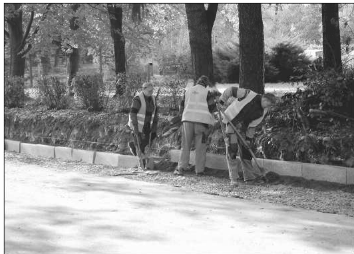
Pracovníci Slumeka usazují obruby nového parkovacího stání na ulici Sadové. Práce by měli dokončit do 17. listopadu. Nové parkoviště má usnadnit situace odstavení osobních vozů. FOTO: DANA HOĐÁKOVÁ
