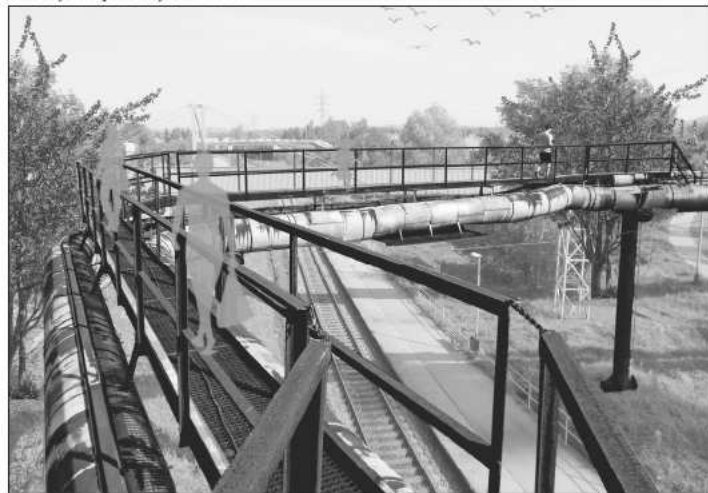
Nadzemní vedení horkovodu by podle některých architektonických vizí nemuselo zmizet, ale mohlo by se proměnit v atraktivní vyhlídkovou trasu v korunách stromů.
