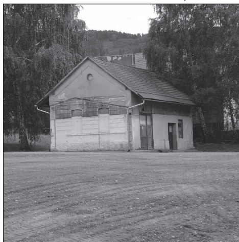
Až odbourání pozdějších přístavků odhalilo neušlechtilé detaily někdejšího hospodářského stavení Šustalovy vily. FOTO: DAVID MACHÁČEK
