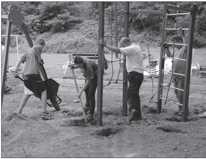
Zaměstnanci stavební firmy instalují vybavení dětského hřiště, které si vybrali sami jeho budoucí uživatelé. Nyní už hřiště v Lubině slouží dětem.
