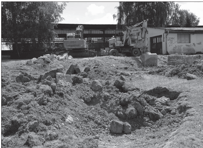
Rekultivace prostoru po zřícení pavilonu muzea začala bouráním doposud neviditelných betonových záklád pod trávníkem. Demolice budov bude následovat v dalších týdnech. FOTO: DAVID MACHÁČEK
