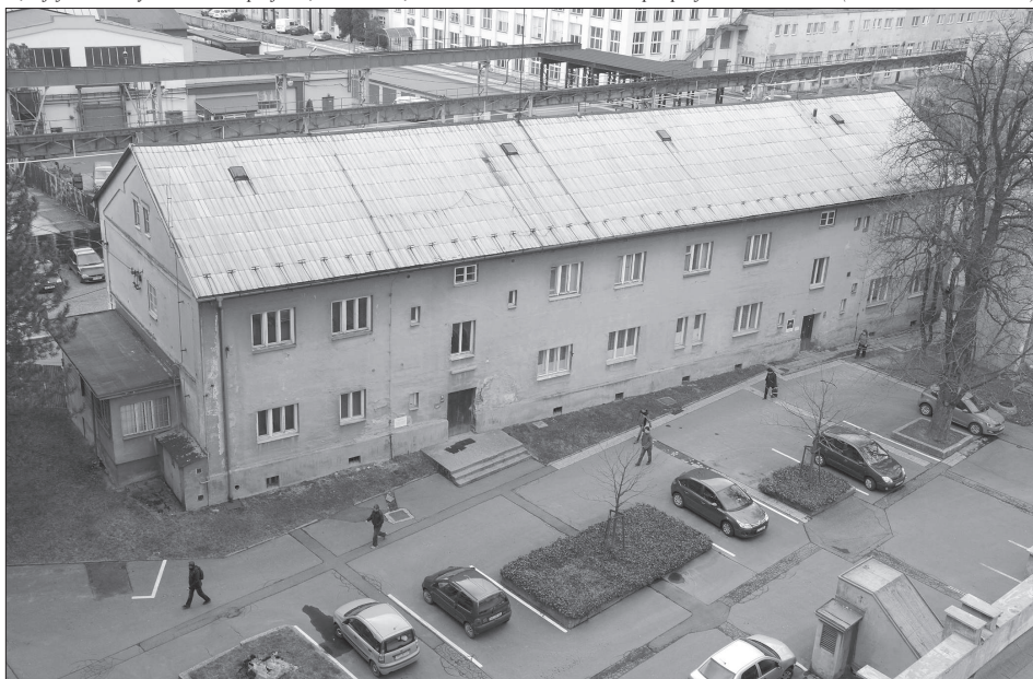
Zastupitelé minulý týden schválili kupní smlouvu objektu někdejšího domu lékařů Tatro. Pokud se podaří získat dotaci z Regionálního operačního programu, nevyužívaná budova bude ještě na podzim zbourána. FOTO: DAVID MACHÁČEK
